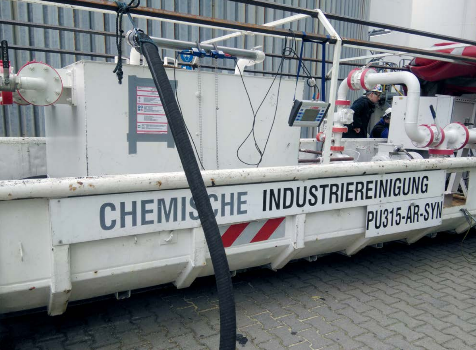
Mit der speziell auf dieses Produkt zugeschnittenen Reinigungslösung wird der Wärmetauscher gespült.
