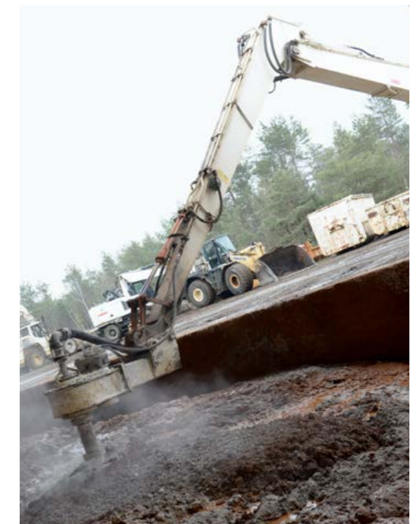
Durch Öffnungen in der Winde können Zuschlagstoffe eingemischt werden.
