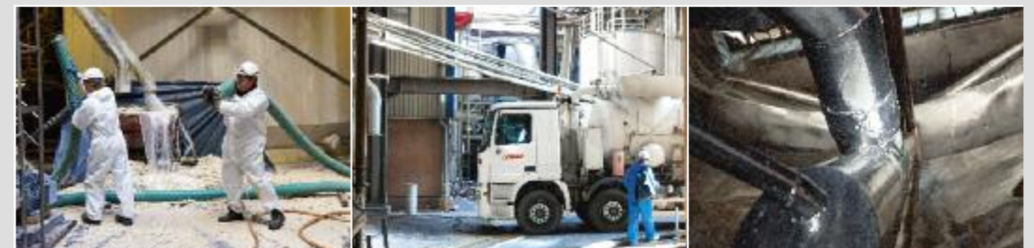
Vorbereitung für Saugarbeiten im Kessel 6 und den Mühlen des Kraftwerks. Rechts ein blitzsauberer Kessel 6 nach der Reinigung.
