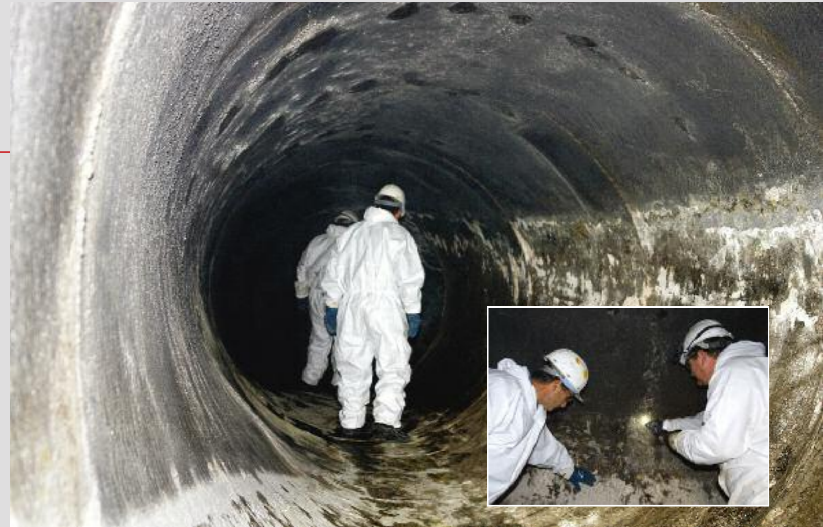
Nach dem Absaugen von Feststoffen im Rauchgaskanal erfolgt die Prüfung des Reinigungsgrades. Weitere Arbeitsschritte waren nicht notwendig.
