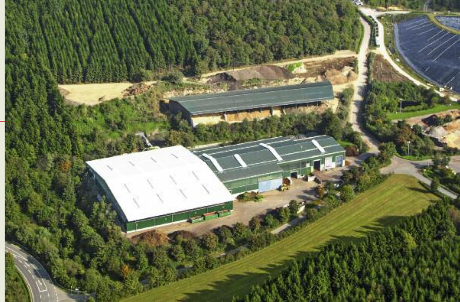
Blick auf den geschlossenen Hallenkomplex des Olper Entsorgungszentrums (OEZ) mit der vor einigen Monaten in Betrieb genommenen neuen Kompostierungsanlage. Bis zum Jahr 2022 werden etwa 50.000 Tonnen Bioabfälle aus den südwestfälischen Kreisen Olpe und Siegen-Wittgenstein angeliefert.
