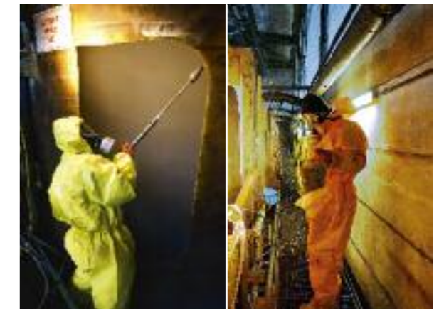
Arbeiten unter Vollschutz: Um sich unter anderem vor dem säurehaltigen Spülwasser zu schützen, treffen die verantwortlichen Mitarbeiter umfassende Schutzmaßnahmen.
