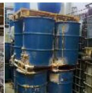
Behälter sind demoliert, aufgeplatzt, in Schiefelage, völlig durcheinander und unsachgemäß gelagert. Die Bergung von Flüssigkeiten und pastösen Substanzen vollzog sich unter Vollschutz. Für Projektleiter Ronald Schultz (Foto rechts, Mitte) hatte die Sicherheit seiner Mitarbeiter oberste Priorität, entsprechend regelmäßig wurden die Sicherheits- und Verfahrenshinweise besprochen.
