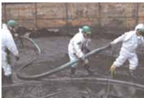
Vorher, nachher. Insgesamt wurden rund 750 Tonnen Teer, 200 Tonnen Schlämme sowie 160 Tonnen Boden und Steine aus dem Gasometer entfernt. Die Abschlussreinigung erfolgte mit Wasserhochdruck.
