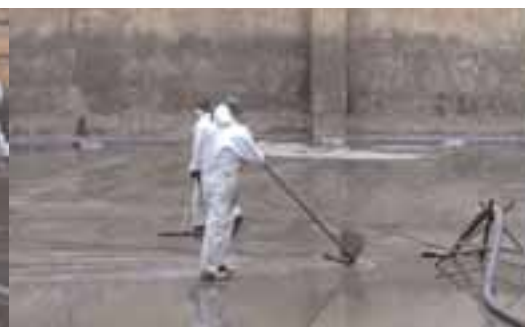
Vorher, nachher. Insgesamt wurden rund 750 Tonnen Teer, 200 Tonnen Schlämme sowie 160 Tonnen Boden und Steine aus dem Gasometer entfernt. Die Abschlussreinigung erfolgte mit Wasserhochdruck.
