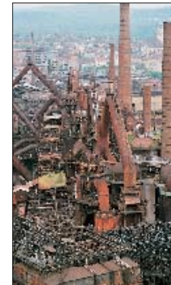
Das Stahlwerk in Völklingen ist mit dem Stadtkern regelrecht verwachsen.
