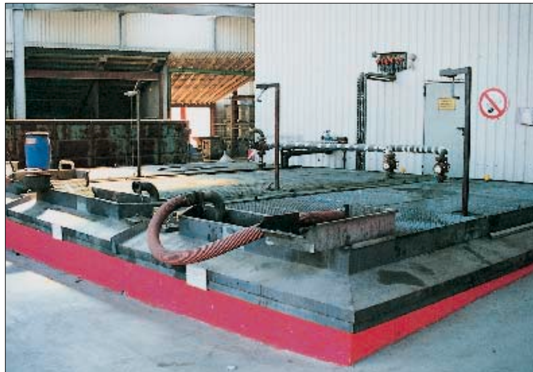
Foto oben: Die Rampe mit Eingang zur Dispo und zum Labor. Foto links: Annahmebecken für flüssige Sonderabfälle (links) - genauso blitzsauber wünschen sich das die Behörden.
