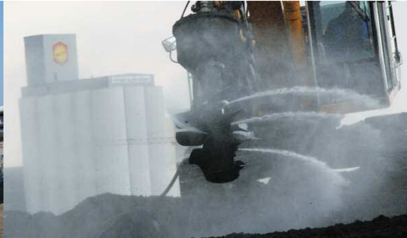
Mit ein paar Handgriffen war die Vertikalfräse in Mannheim zum „Wassersprenger“ umfunktioniert.
