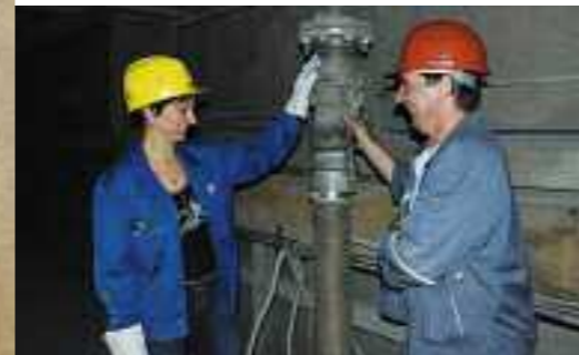
Martina Friedrich und Rico Fiedler haben im Stahlwerk Riesa schon einige Stillstandsmaßnahmen reibungslos abgewickelt. Hier präsentieren die beiden einen fest installierten Rohrstützen für den Anschluss von Lufförderanlagen. Diese Lobbe-Idee wurde von der Werksleitung umgesetzt.
