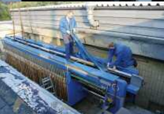
Abbau der Kammerfilterpresse in Hagen-Hohenlimburg und Transport ins nur fünf Kilometer entfernte Iserlohn-Letmathe.
