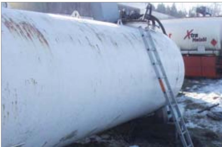
))) Der Unglückstank stand im Freien, hatte ein nicht zugelassenes Ausgleichsgefäß.
