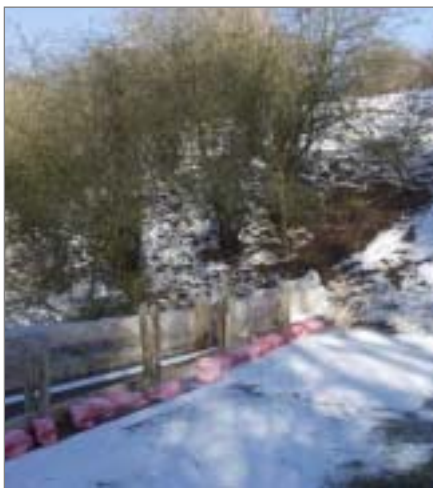
))) Eine von insgesamt 8 Ölsperren der Feuerwehr.
