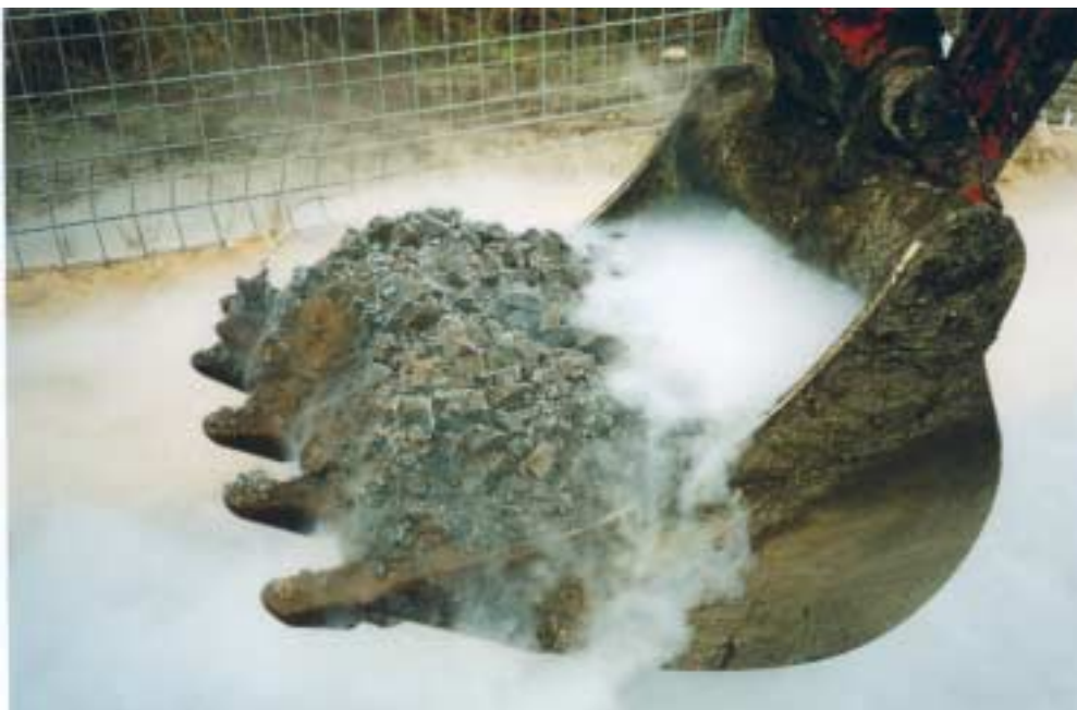
Bild: Versprödeter Teer bei der Bergung
