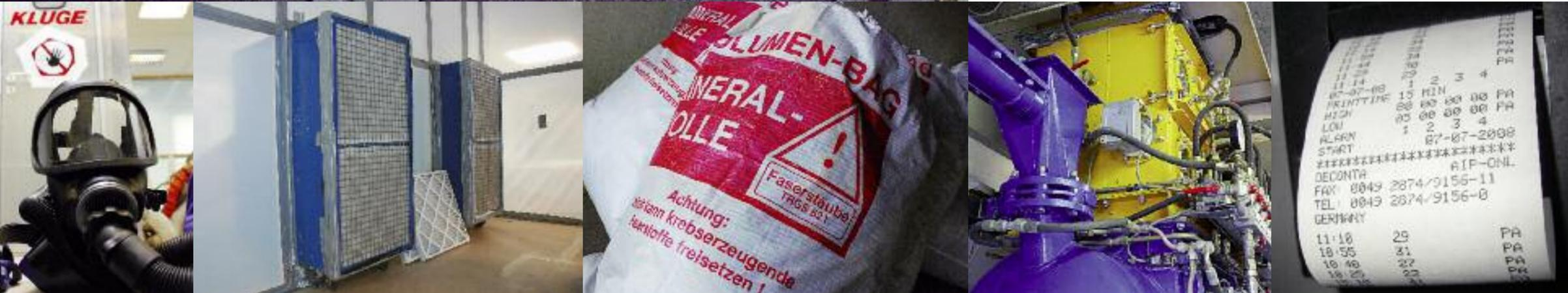
Sicherheit steht an erster Stelle. Mehrkammer-Personalschleuse, Atemschutzmaske, Abschottung mit Abluffilterung, Spezial-Verpackungen, Asbest-Verfestigungsanlage und Monitoring der Unterdruckhaltung.
